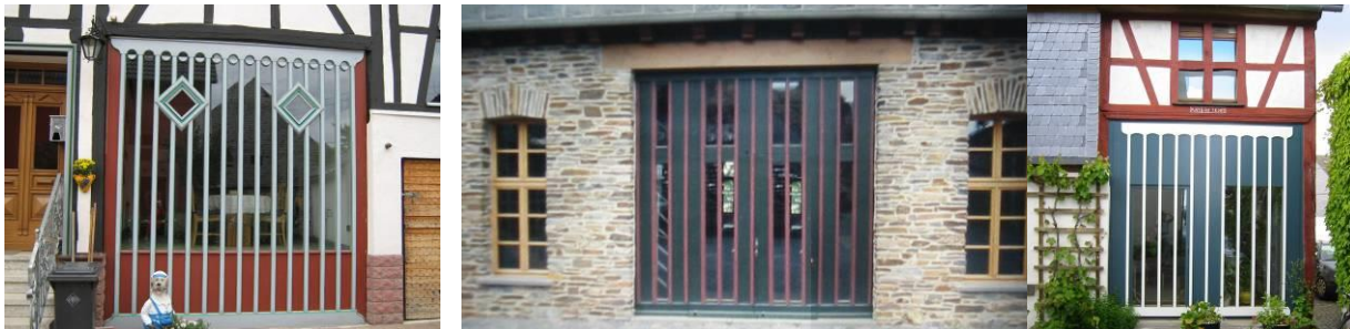
Beispiele für umgebaute Tore mit Glaseinsätzen
